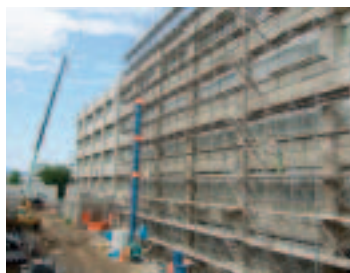
工事中のD棟
